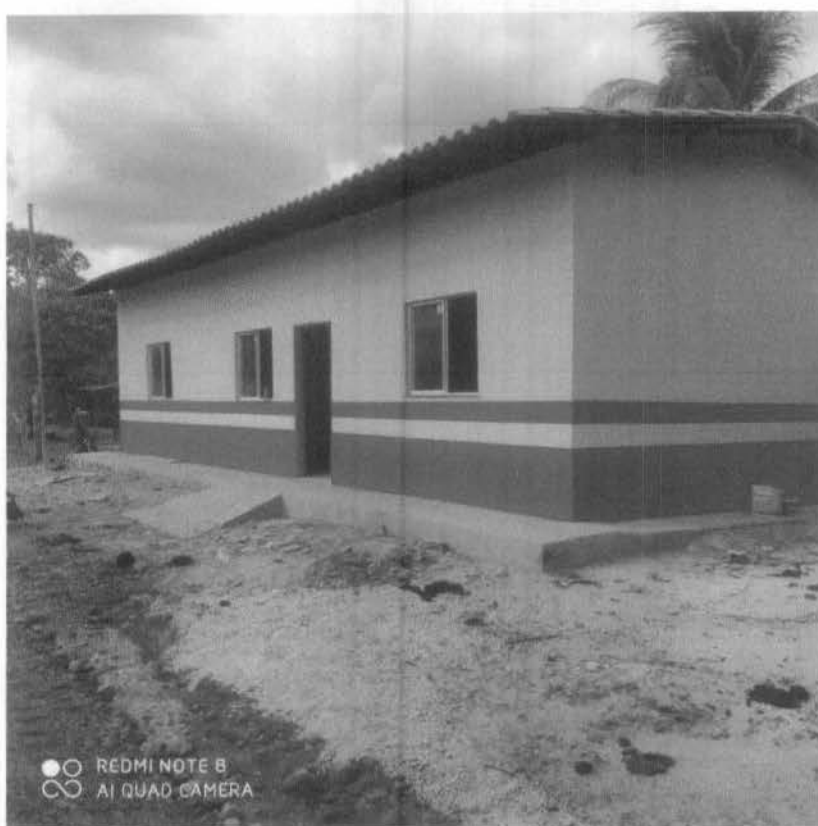
Imagem 3 – Serviços de pintura e recuperação de reboco
