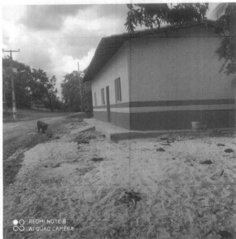
Imagem 2- Serviços de Pintura
